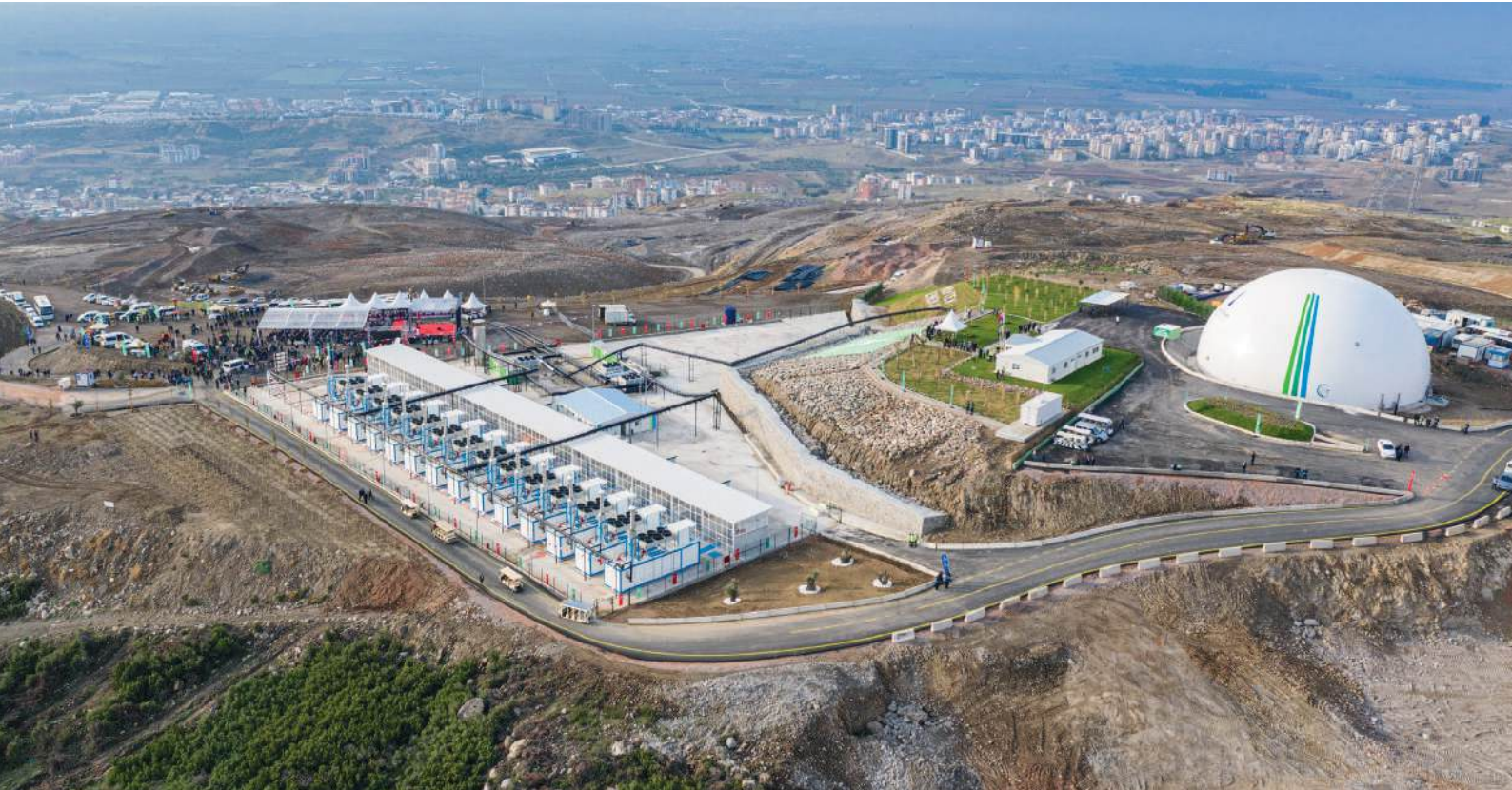
Harmadalı Düzenli Atık Depolama ve Biyogaz Tesisi
