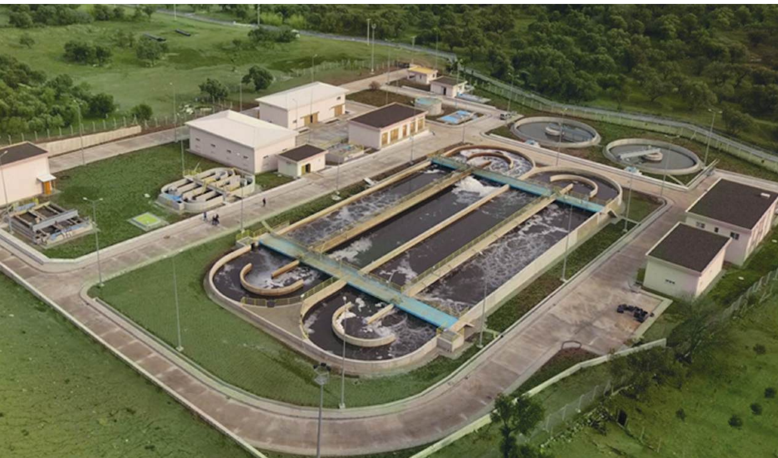
Çiğli Atık Su Arıtma Tesisi
